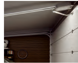
Montaż na wale
