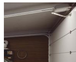
Montaż na wale
