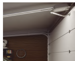
Montaż na wale
