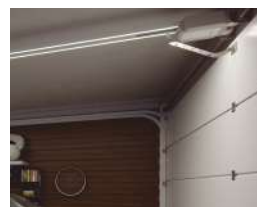
Montaż na wale
