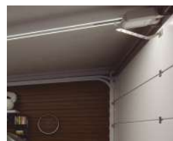
Montaż na wale
