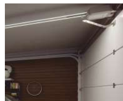
Montaż na wale
