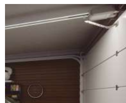
Montaż na wale
