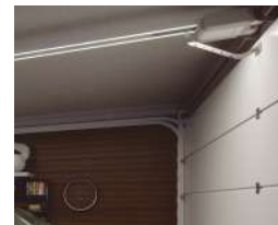
Montaż na wale
